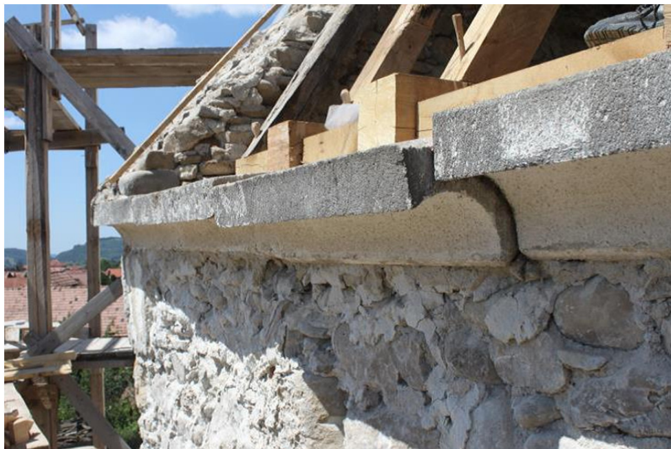
Restaurálás előtti, helyéről kimozdult ereszpárkány
