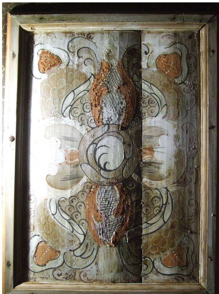
A kazettás mennyezet egyik táblájának restaurálás előtti állapota
