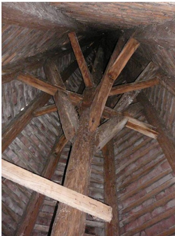
A torony fedélszerkezetének belső képe
