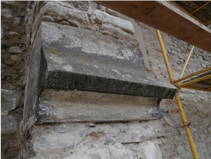
Támpillér csepegtető különböző lerakódásokkal, biológiai szennyeződéssel, mészréteggel
