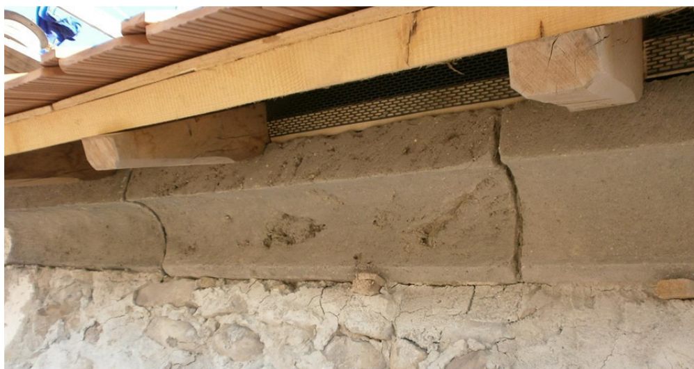
Letisztított ereszpárkány az eltávolított cement alapú fugákkal, előkészítve az újrafugázáshoz
