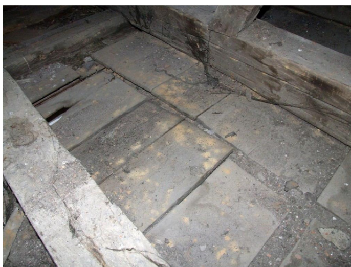
A festett kazettás mennyezet szennyezett és rovarfertőzött hátoldala
