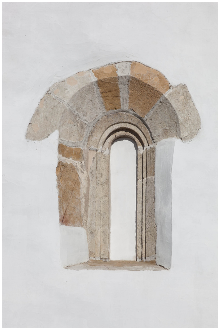
9. kép. A déli fal restaurált románkori ablaka
