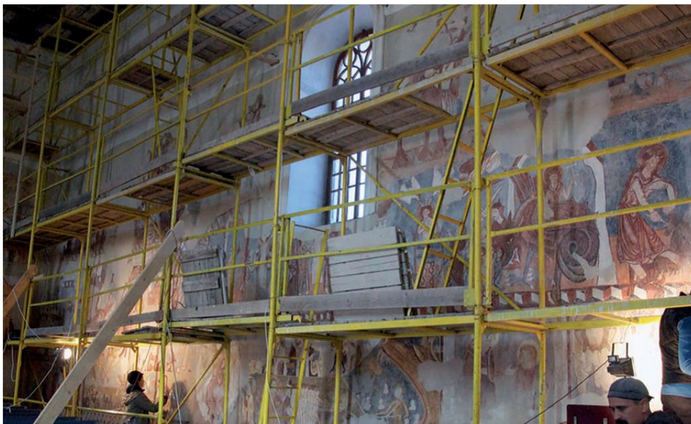
A bögözi református templom északi fala a konzerválás után, az esztétikai helyreállítás közben
