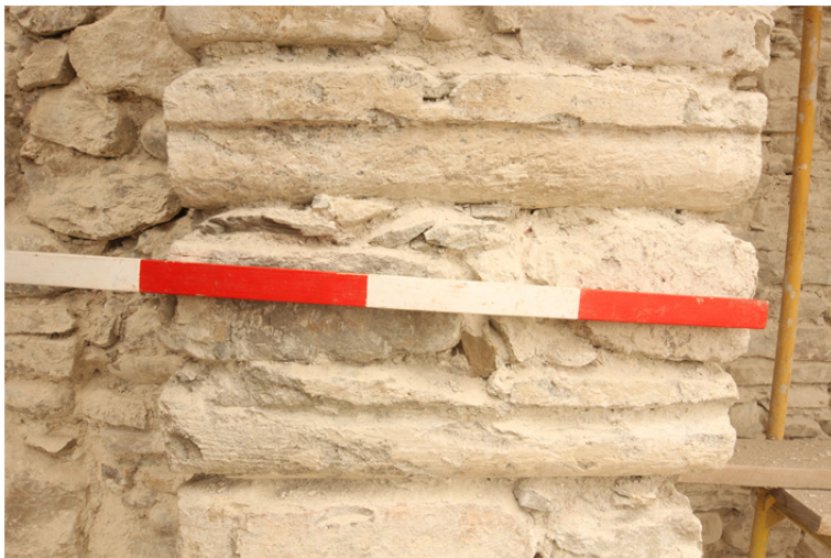
11. kép. A gótikus támpillérbe másodlagosan beépített románkori faragott kövek
