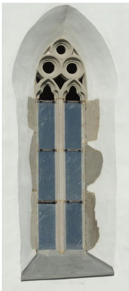
Gótikus ablakkeret rekonstrukció
