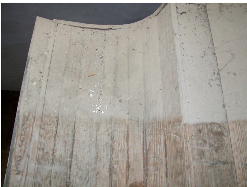
A pad teteje tisztítás közben
