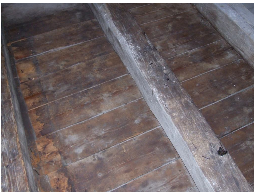
A festett kazettás mennyezett letisztított hátoldalának biológiai kártevők elleni megszüntető és megelőző fertőtlenítése
