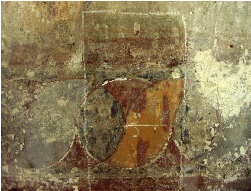
Tisztítási próba az alsó regiszter cementtel takart díszítősávján.
