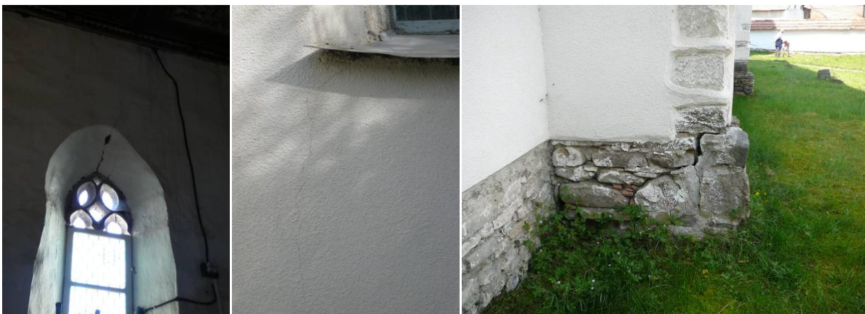
11. ábra – a felmenő szerkezet tartószerkezeti elégtelenségei: repedések (a) a hajó nyílásáthidalásán (b) a szentély parapet falán, illetve egy hajó-támpillér esetében
