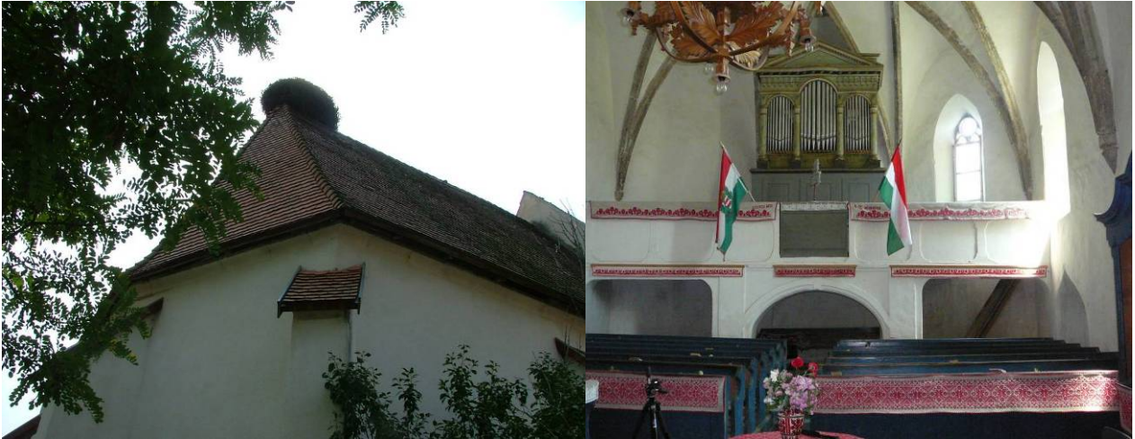
7. ábra – a hajó felmenő szerkezetei: (a). a támpillérekkel merevített tartófal, (b). a karzattal tartó falazott téglaszlopok
