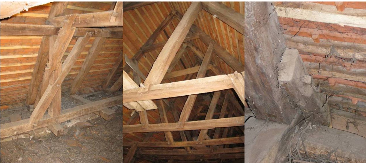
2. ábra – a szentély fedélszerkezete: (a). fő-szaruállás és hosszanti merevítő síkrendszer metszete, (b). a fedélszerkezet második és harmadik szintje, (c). lapolt, keményfa csappal rögzített vízvető
