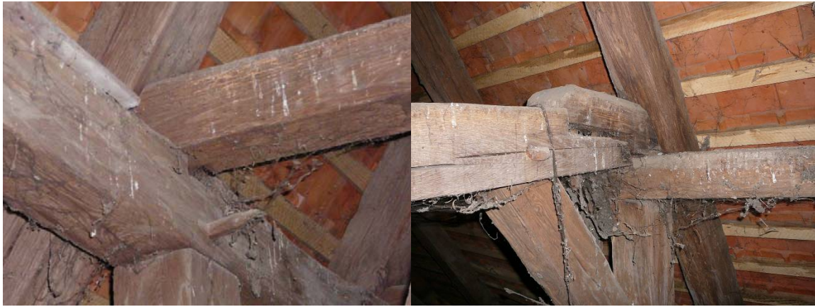
10. ábra – a tetőszerkezet tartószerkezeti elégtelenségei: (a) merevtesti elmozdulások – a hosszanti merevítő síkrendszer eltávolodása a szaruállástól, (b) hasadások egy torokgerendánál
