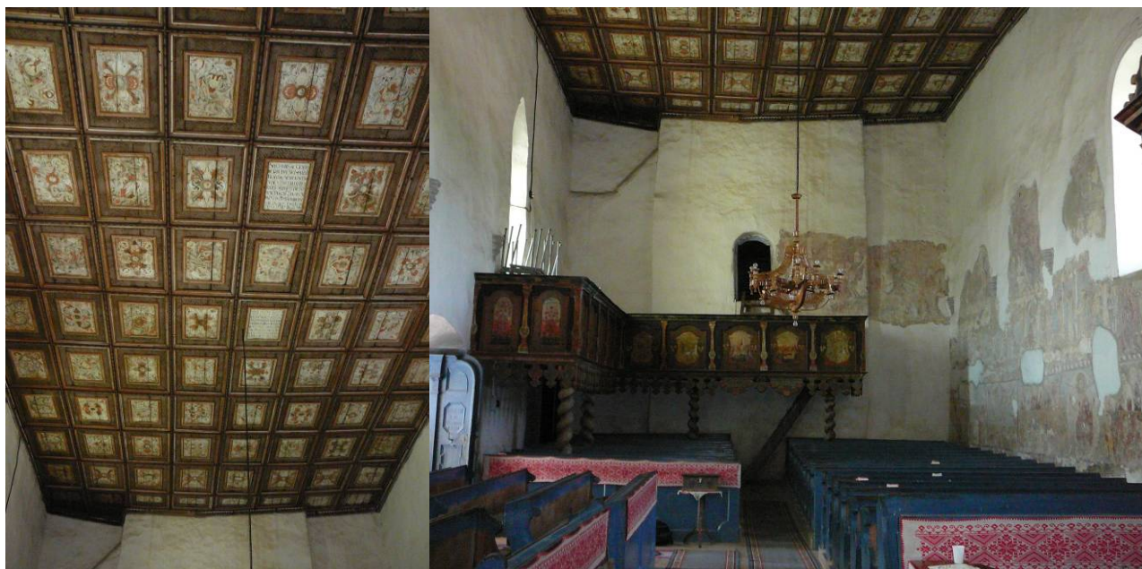
6. ábra – a hajó födém szerkezetei: (a). a kazettás tetőfödém, (b). a kazettás tetőfödém és a karzat sík fa födémé
