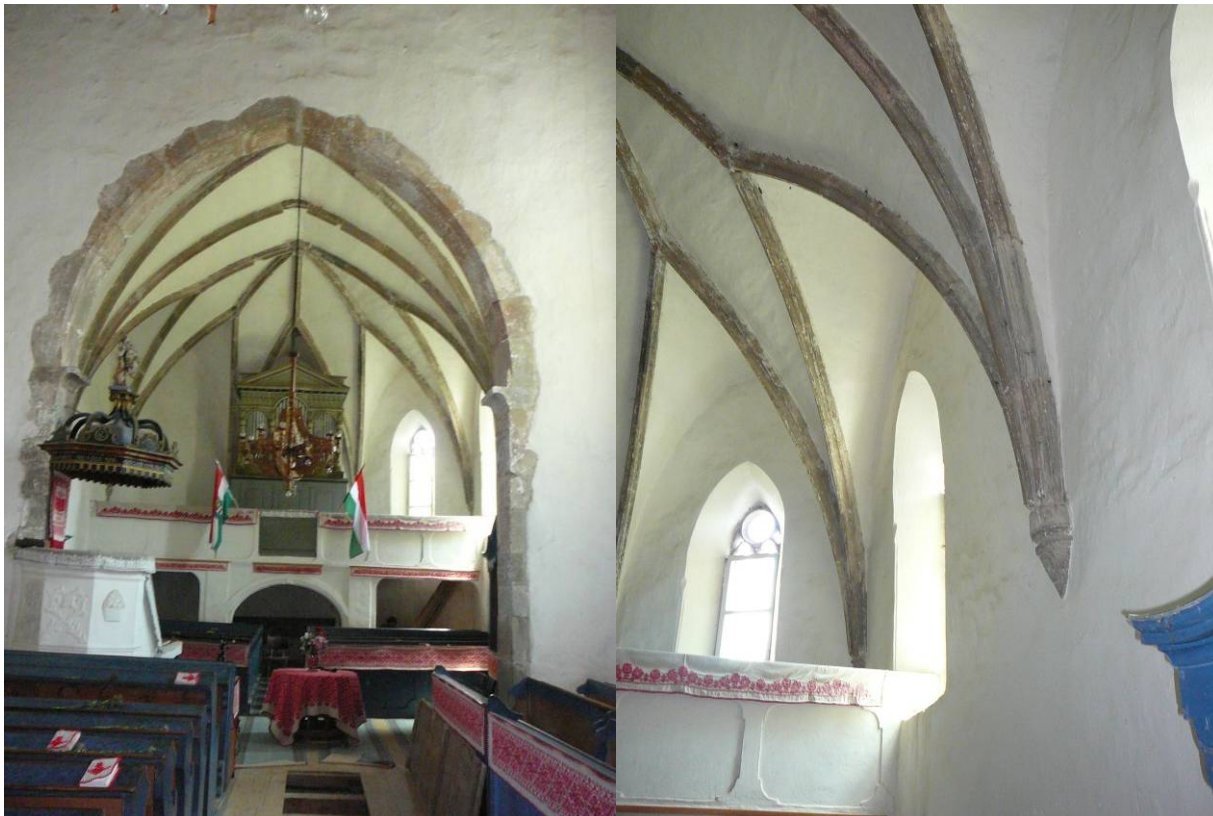
5. ábra – a szentély födém szerkezetei: (a). boltozott tetőfödém és vegyes (boltozott falazott, illetve sík fafödém) karzatfödém, (b). boltozott tetőfödém-részlet
